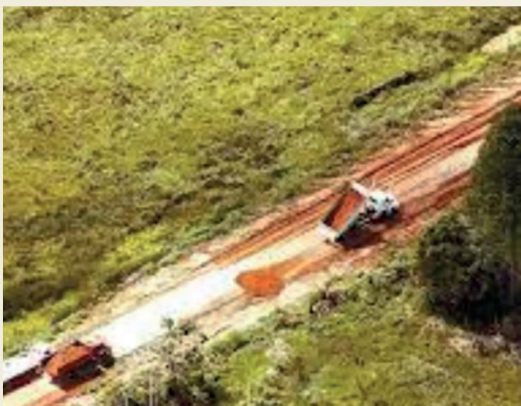
Construção da estrada Manaus-Porto Velho
